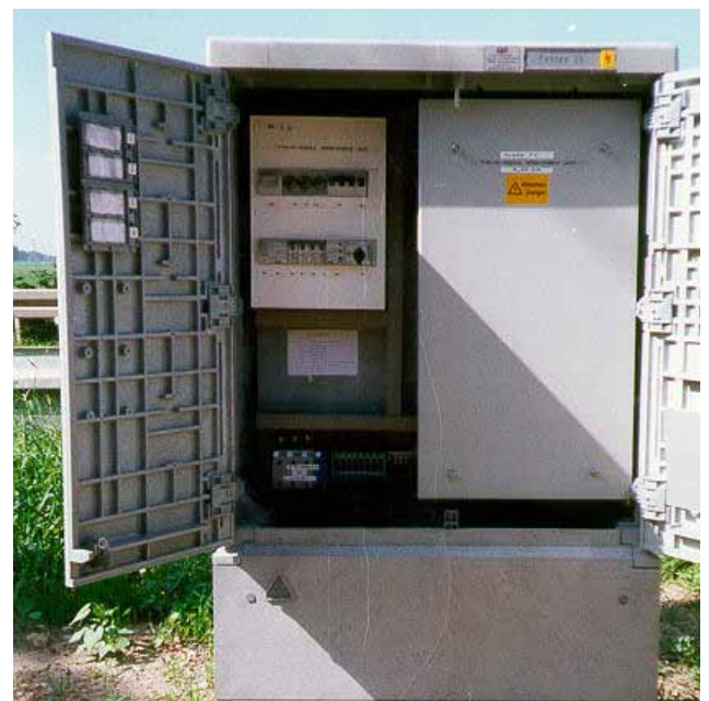
Referenzobjekt Posten 25 bei Gorsleben Bahnstrecke Erfurt-Sangerhausen Variante 6,3 kVA Trenntrafo
